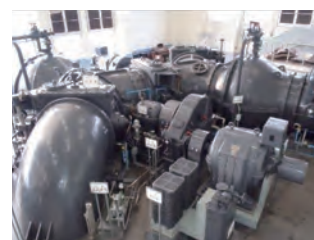
(現)手賀排水機場
