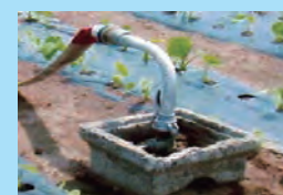
※ 給水栓に消火ホースを接続
