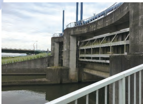
▲利根川両総水門
