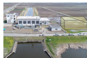
手賀第二排水機場
